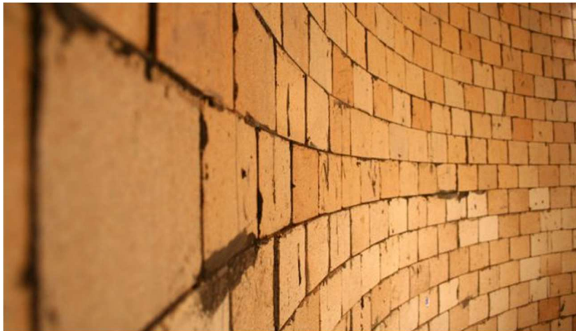
Abbildung 2: Beispiel einer mit Mörtel verfugten Feuerfest-Zustellung [4]
