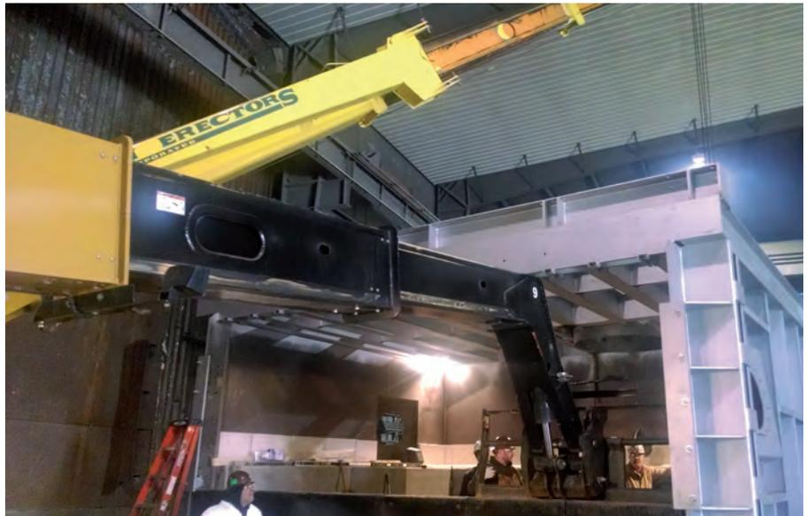
*Komplette Neuzustellung innerhalb von 7 Tagen eines 20MT Al Schmelzofens mit 1 Supervisor, 4 Helfern, einem Teleskopstapler und einem Autokran/Kunde Gießerei von Al Gehäusen für Tablets und Mobiltelefone*
