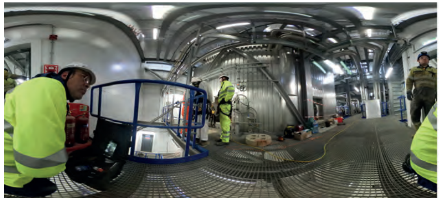
Abbildung 2: 360° Inspektion eines Müllkessels vor der Reinigung zur Freigabe
