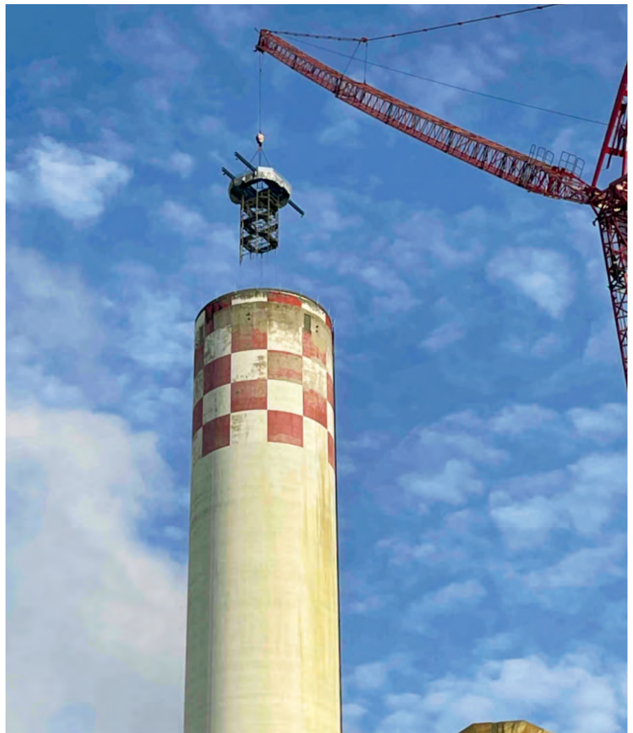
Bild 3: Einheben des Arbeitsgerüsts mit 650-to-Mobilkran
