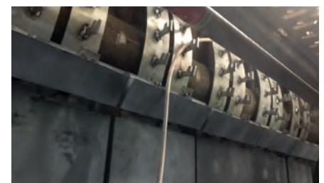
Abbildung 14: Beankerung und Montage der Haltebügel
