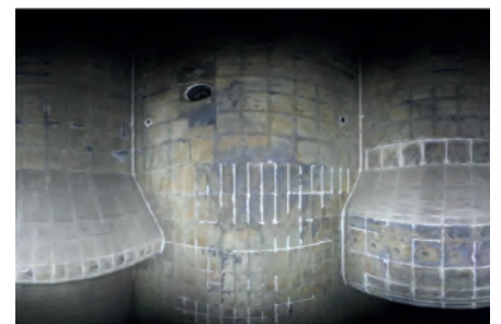
Abbildung 3: 360° Blick auf hinterlüftete Zündeckennase und Einschnürung
