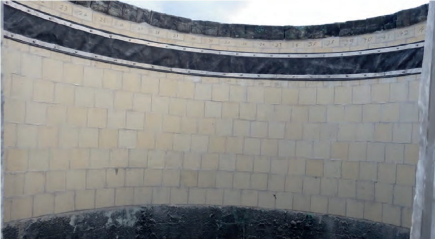
Bild 5: Mündung Linie 1 instandgesetzt
