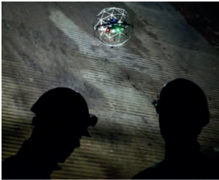
Abbildung 1: Inspektionsdrohne im Einsatz
