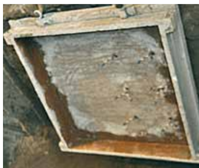
Bild 1: Großes Panel „vor dem Spritzen“
